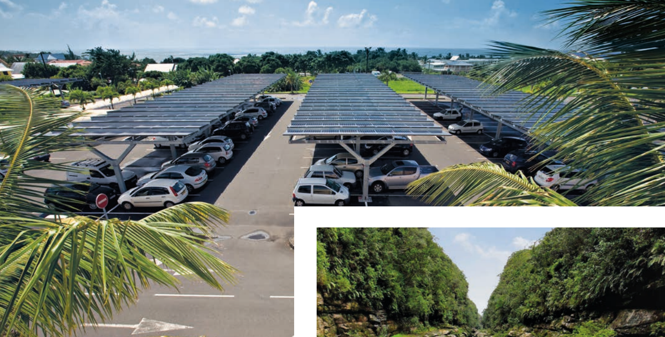
— Desde 2007, graças à expertise de sua filial GreenYellow, o Grupo Casino instalou 65 usinas solares no teto de suas lojas e na cobertura de estacionamentos. Atualmente, a empresa opera 15 usinas para autoconsumo.
